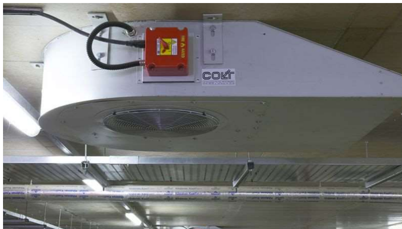
Figura 1 - Ventilador centrífugo para exaustão em ambiente de garagem.
